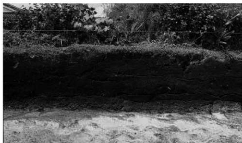
A地区北西壁 土层断面
